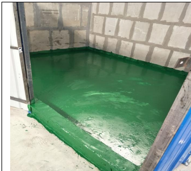
危废暂存间（防渗、围堰）
